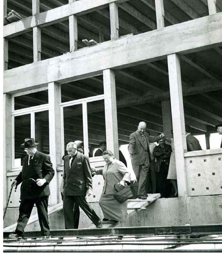
Visite de chantier au Chaperon Vert en 1957
