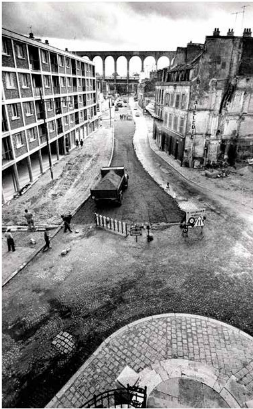
Démolition et construction de l'îlot Raspail
