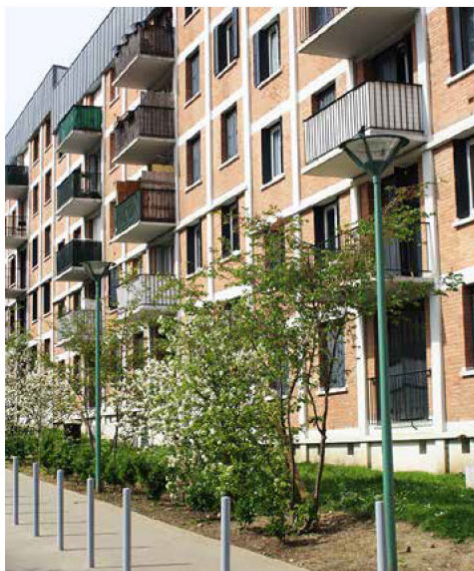
La Vache Noire réhabilitée (arrière du bâtiment)
