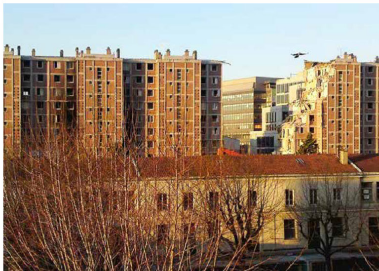
La démolition du bâtiment A
