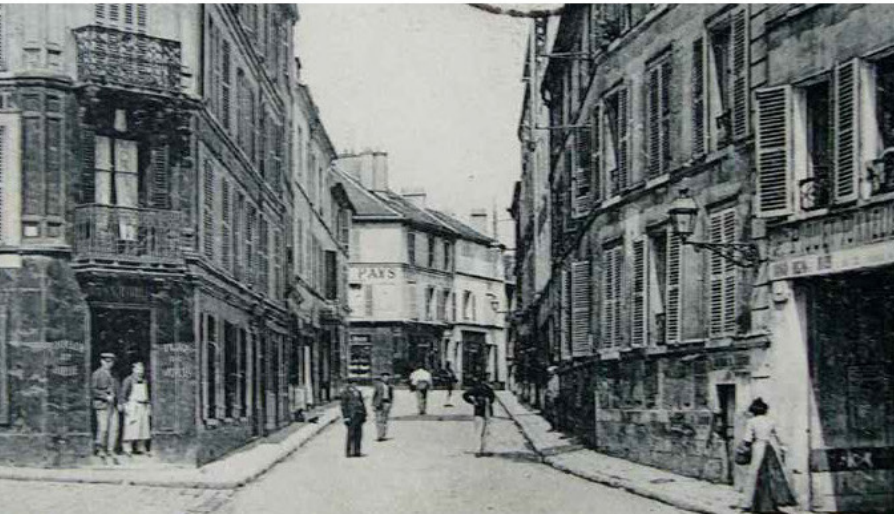
La rue Frileuse avant la rénovation
