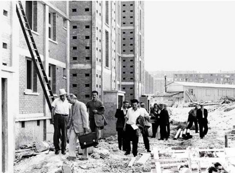
Visite du chantier de l'extension Chaperon Vert
