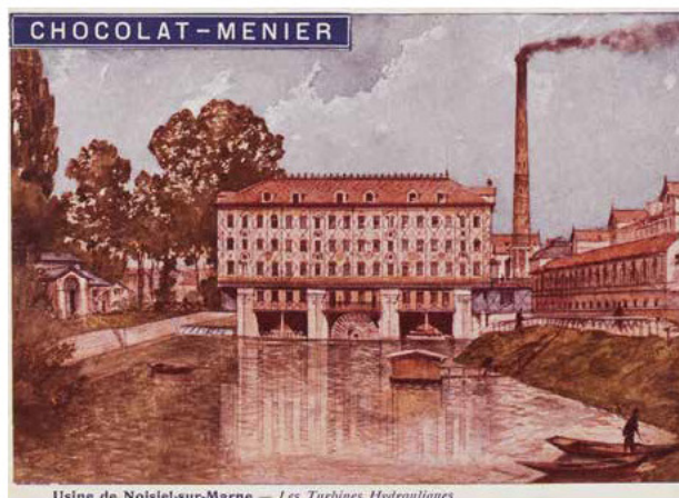
Usine de Noisiel-sur-Marne — Les Turbines Hydrauliques
