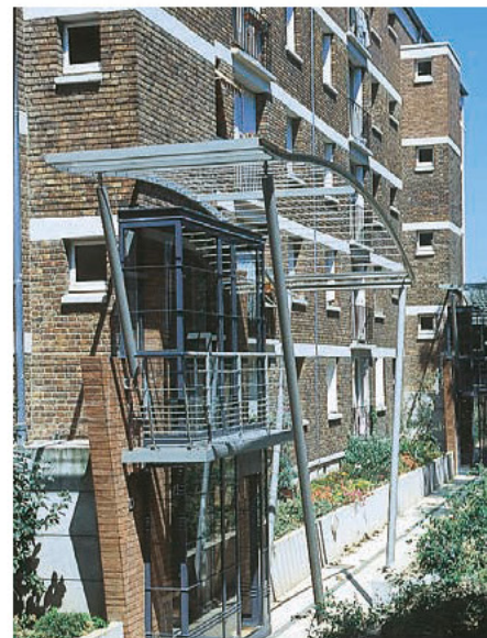
Réhabilitation des halls d'entrée à Paul Vaillant-Couturier ainsi que des logements et des parties communes
