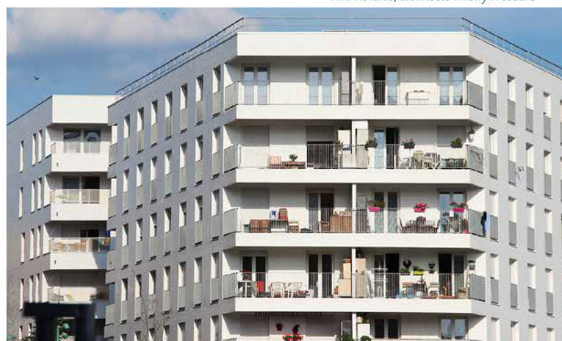
Villa Mélanie, architecte Thierry Fressard
