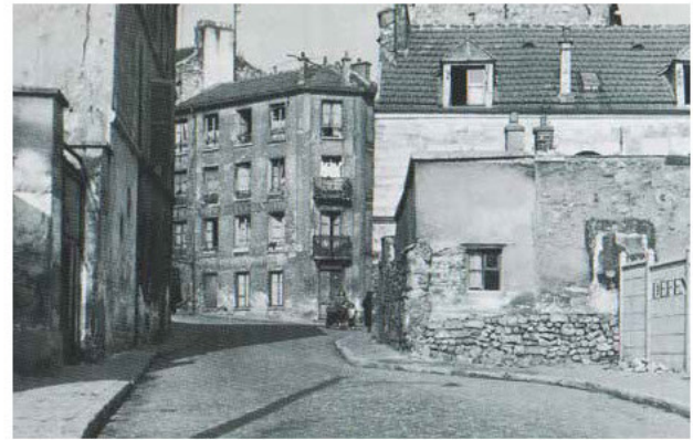
La rue Frileuse avant la rénovation
