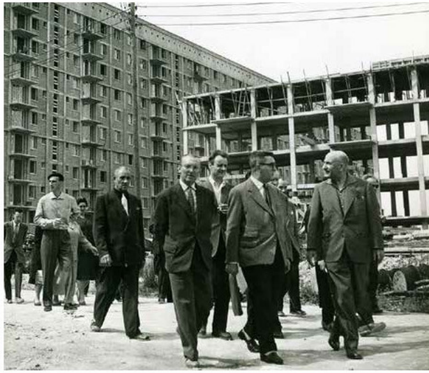
Visite de chantier au Chaperon Vert en 1957
