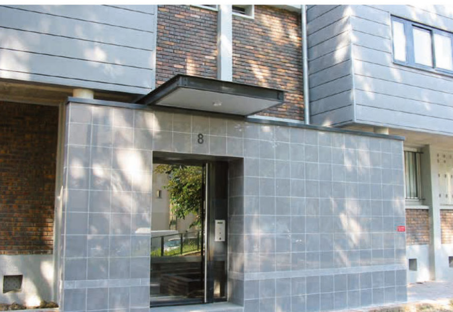
Réhabilitation de la cité Frileuse, architecte agence Daquin et Ferrière
