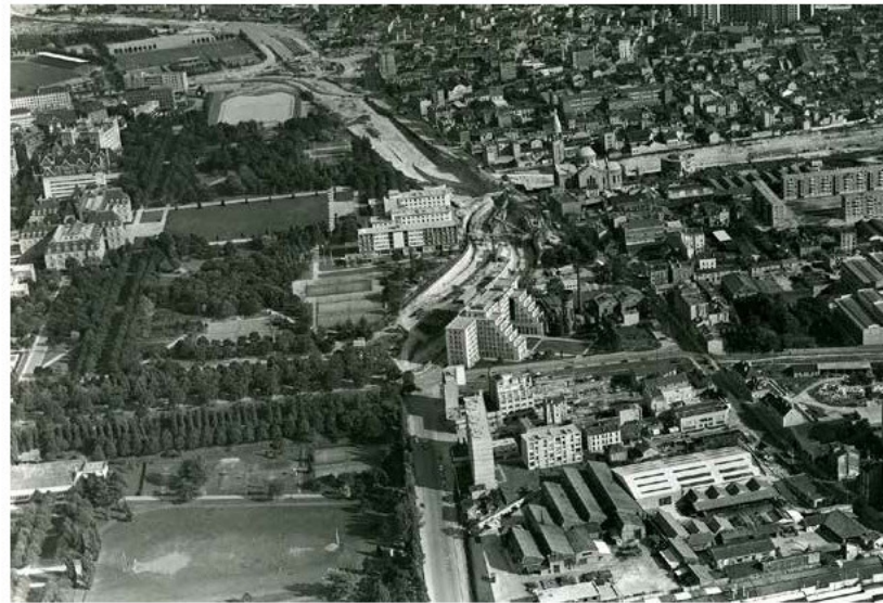
La connexion de l'autoroute au périphérique
