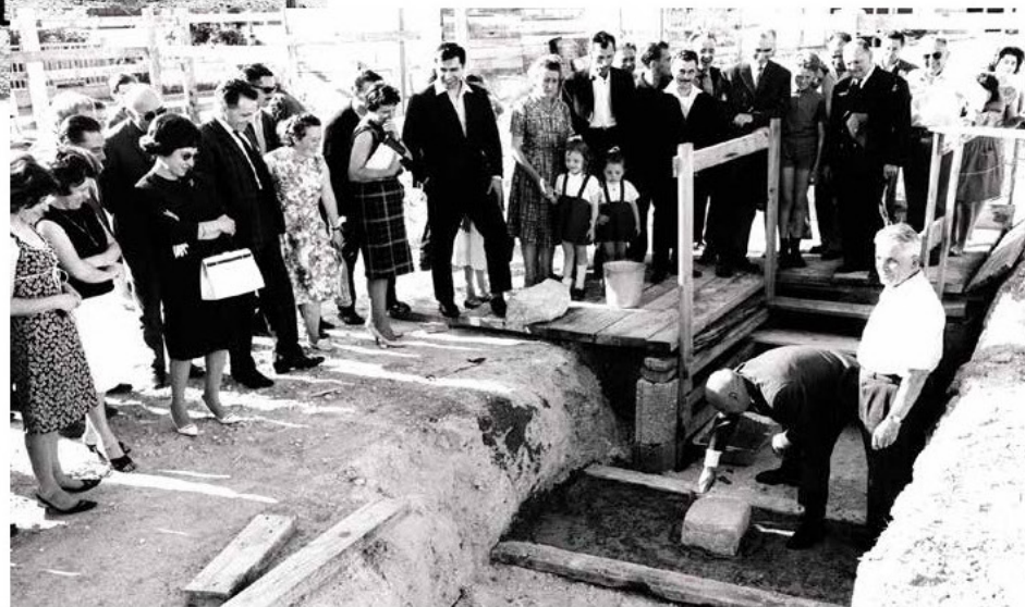
Pose d'une première pierre en présence de Marcel Trignon
