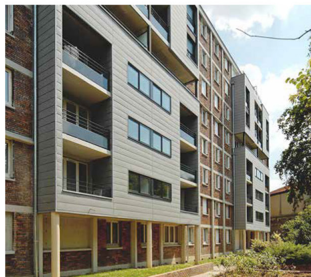
Réhabilitation de la cité Frileuse, architecte Daquin et Ferrière
